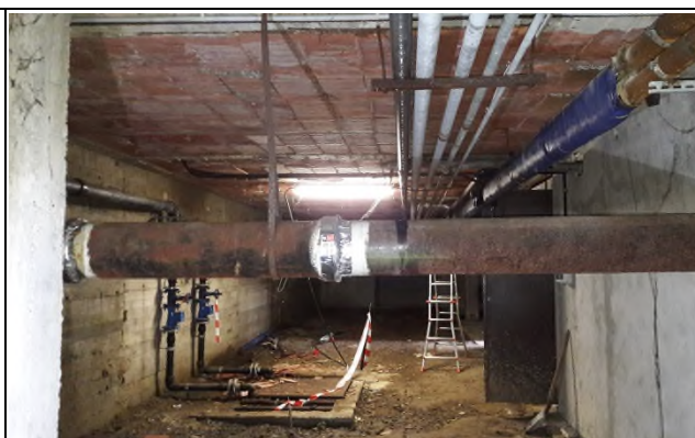
Giunzioni cementizie tubi di scarico
